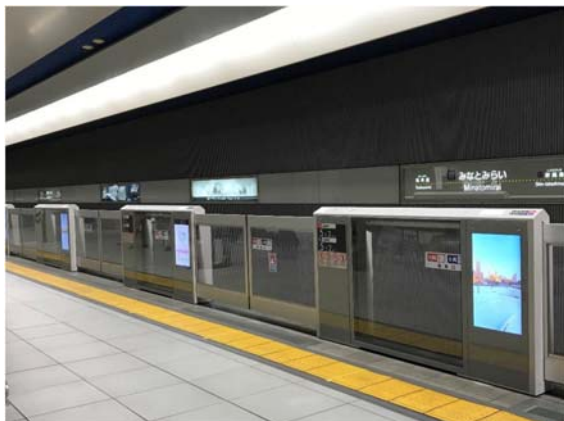
みなとみらい駅の可動式ホーム柵
